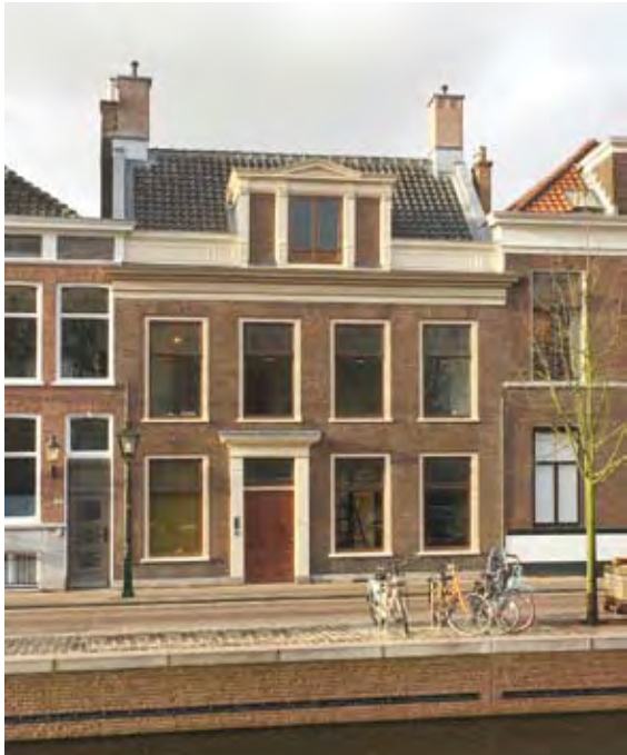
Den Haag, Toussaintkade 22, Huis Tuyt, voorgevel na restauratie (foto Arjan Bronkhorst)
