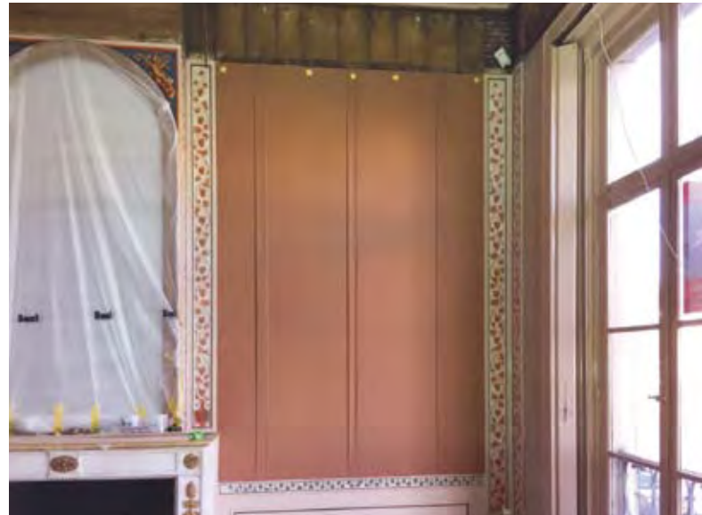
Afb. 17. Proefopzet van de wandbespanning met daarop de sterretjes die bevestigingspunten van de draperie aangeven.
