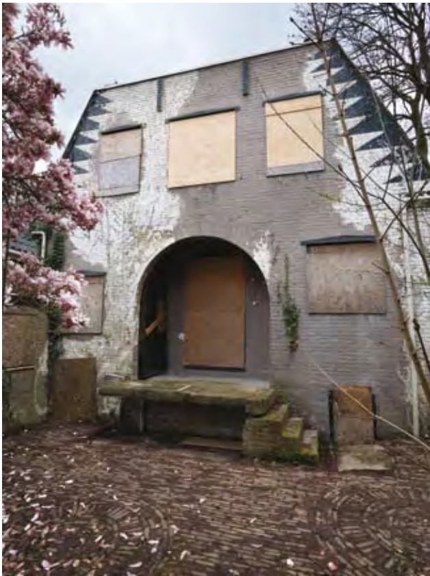
Uithoorn, Thamerlaan 14, achtergevel in 2018 (foto Arjan Bronkhorst)
