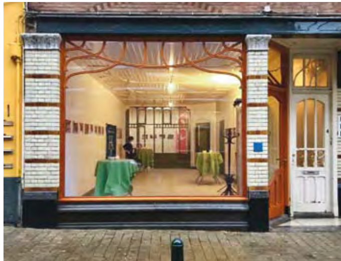
Den Haag, Piet Heinstraat 2B, gevel na restauratie
