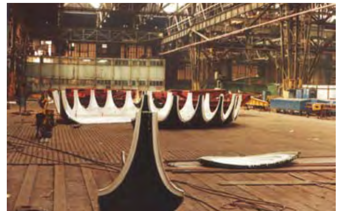
Het frame van de Shelter in aanmaak bij de N.S.M.-werf
