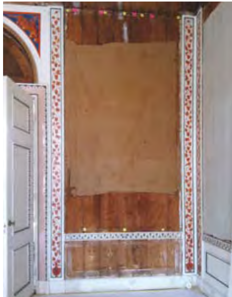
Afb. 16. Met sterretjes zijn de plekken van de clusters spijkergaatjes aangegeven
