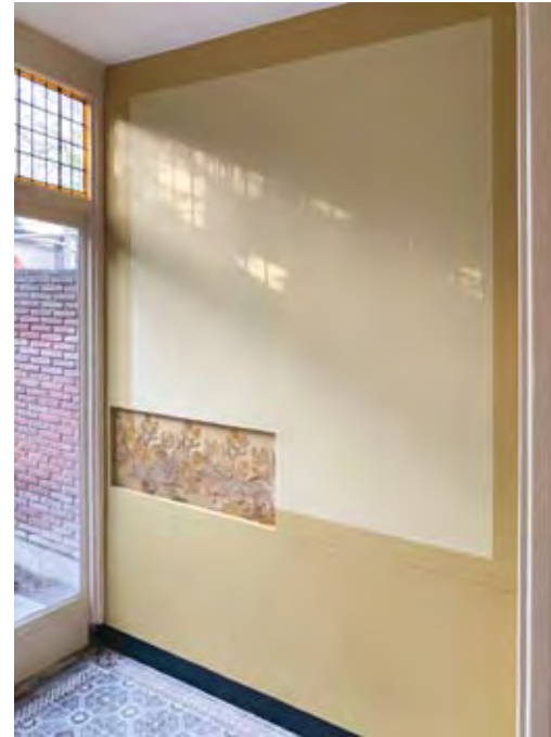
Den Haag, Toussaintkade 22, Huis Tuyt, serre na restauratie met herstelde wandschildering
