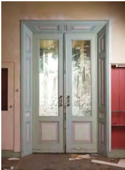
Den Haag, Elandstraat 12, schuifdeuren voor restauratie (foto Arjan Bronkhorst)
