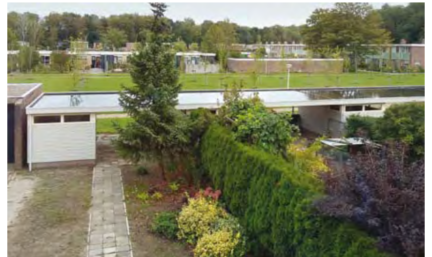
Nagele, Karwijhof 1-32, deel van de strook van bergingen achter de huizen
