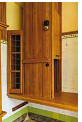
Den Haag, Elandstraat 12, liftje in de eetkamer en in de keuken (foto's Arjen Veldt)
