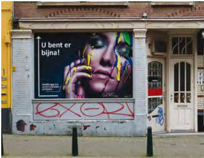
Den Haag, Piet Heinstraat 2B, gevel voor restauratie (foto Arjan Bronkhorst)
