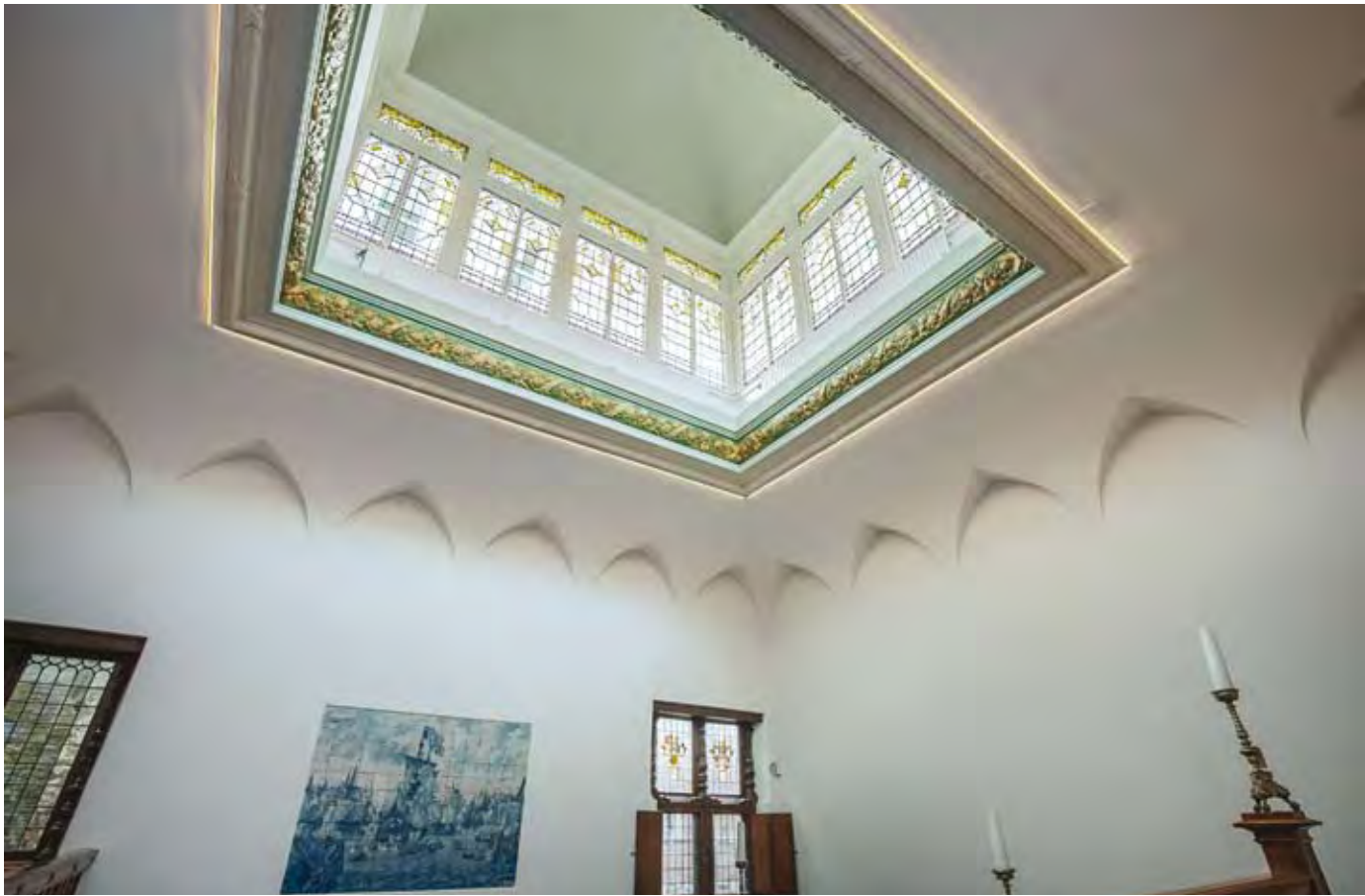
Delft, Oude Delft 199, lichtkoepel na restauratie (foto Zien24)
