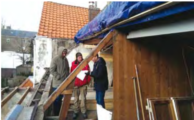
Den Haag, Toussaintkade 22, verwijdering van de gevelbrede dakkapel en herstel van het dak
