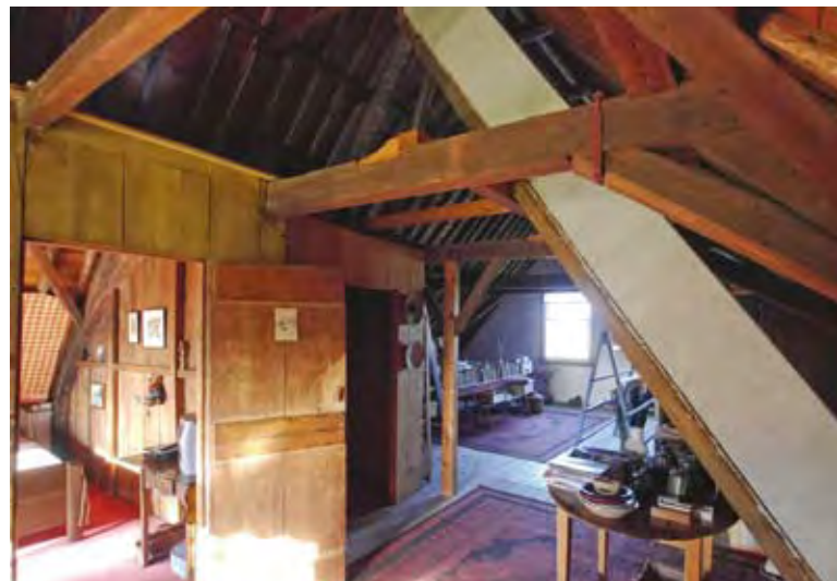
Nederhorst den Berg, Hinderdam 15, zolder met knechtenkamer
