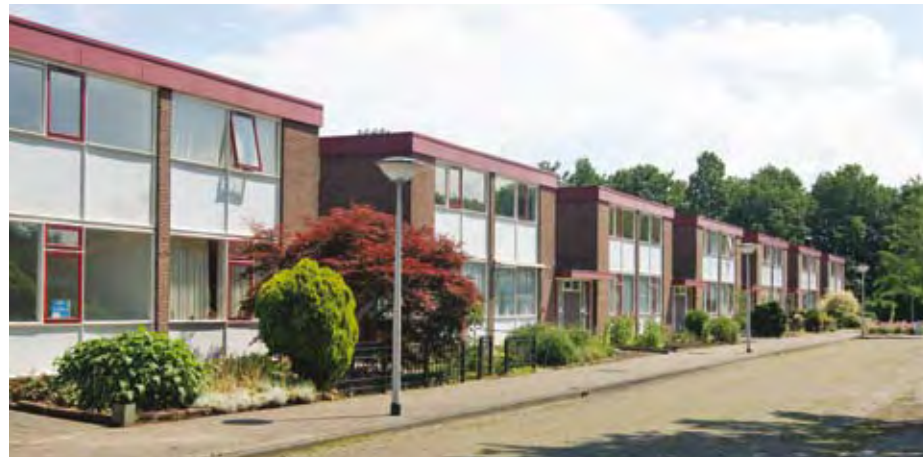
Nagele, Karwijhof 1-32, voor restauratie
