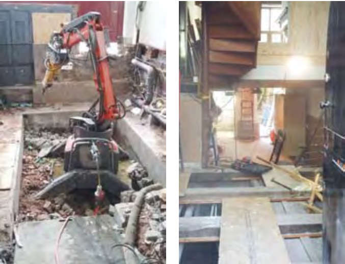
Amsterdam, Bloemgracht 87-91, begane grond tijdens en na het verwijderen van de betonnen vloer
