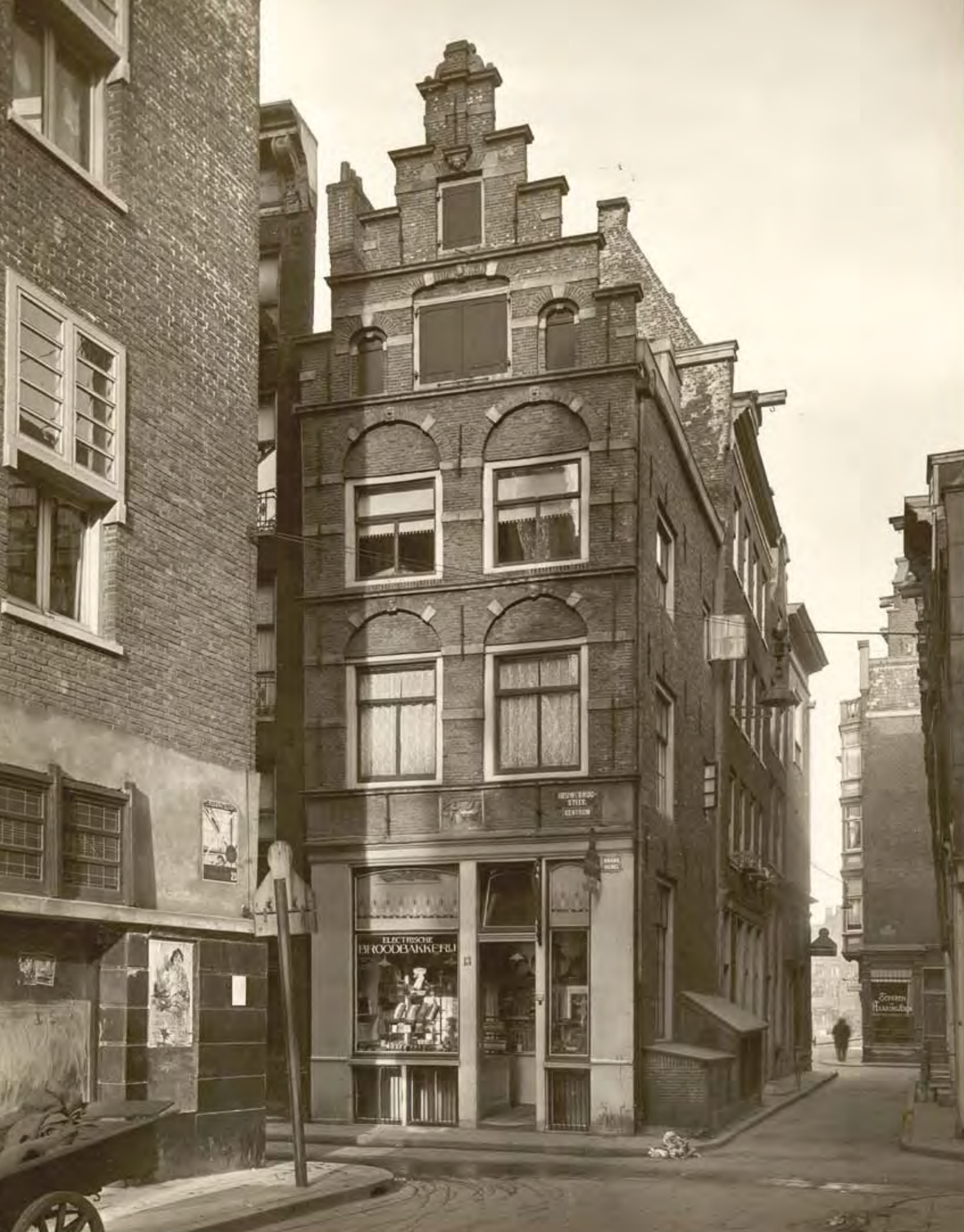
< Afb. 7. De allereerste verwerving van de Vereniging, Nieuwebrugsteeg 13, voor restauratie. Op dat moment was in het pand een 'Electrische Broodbakkerij' gevestigd' (foto Stadsarchief Amsterdam)
