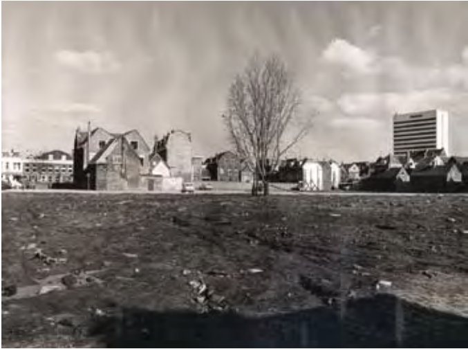
Afb. 28. Het grotendeels kaalgeslagen centrum van Schiedam, ten behoeve van stadsvernieuwing. Links is de achterkant van het pand Oude Kerkhof 5 te zien, dat de sloopwoede overleefde. Vele decennia later zou de Vereniging dit pand verwerven
