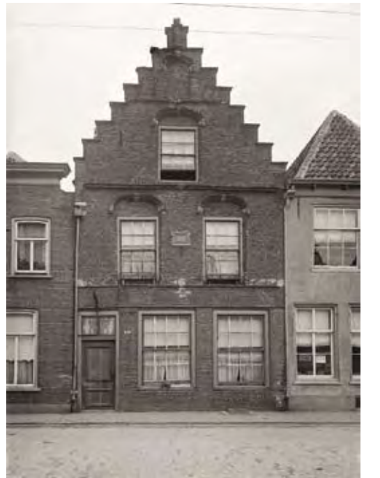
Afb. 21. Het huis in Geertruidenberg, dat de Vereniging in de oorlog verwerf. Naderhand is het pand ingestort (foto Geheugen van Nederland)
