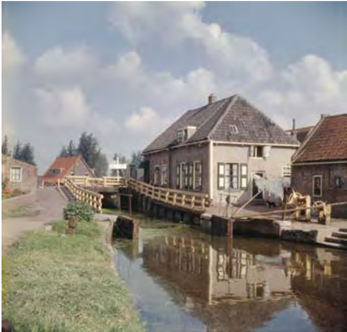
Hekendorp, Goejanverwelle 74, de Goejanverwellesluis anno 1958 (Collectie Rijksdienst voor het Cultureel Erfgoed)
