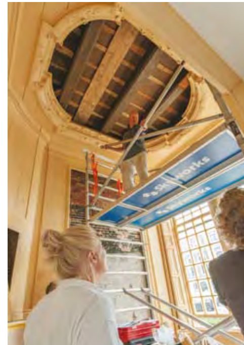
Gouda, Turfmarkt 142, Admiraalshuis, het terugplaatsen van het plafondstuk na restauratie (foto's Margreet Nijman)
