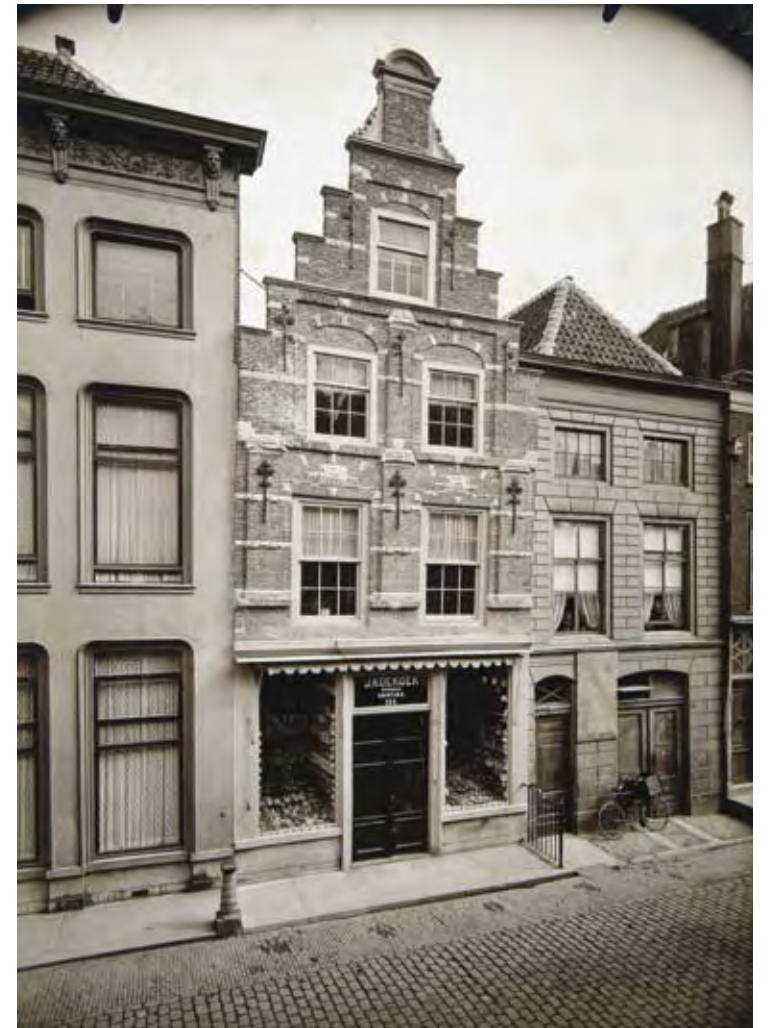
Afb. 8. Voorstraat 170 in Dordrecht na de restauratie (foto Regionaal Archief Dordrecht)
