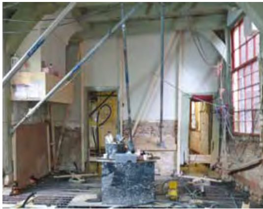
Amsterdam, Kattengat 2-4, vloer met wapening
