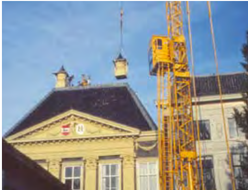
Afb. 52. De hoekschoorstenen worden teruggeplaatst tijdens de laatste fase van de restauratie van ‘De Onbeschaamde’
