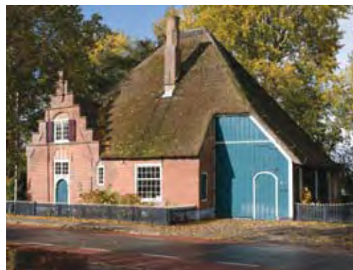
Afb. 49. De boerderij Westerblokker 39 in Blokker (foto Arjan Bronkhorst)
