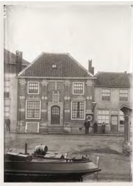
Goes, J.A. van der Goeskade 69, 'Huis Hoope' na restauratie 1916 en in gebruik als sluiswachterswoning (Foto Vishuis, C.J. Steenbergh)
