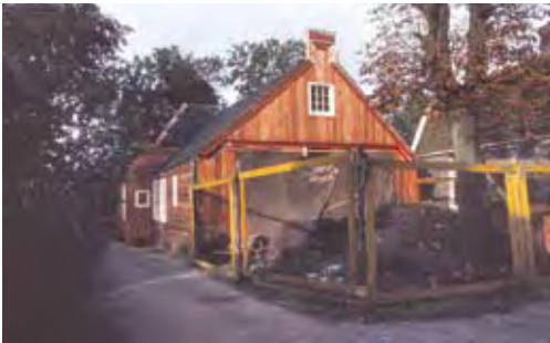
Afb. 32. Het huis Leeteinde 4-6 in Broek in Waterland tijdens de restauratie in 1968
