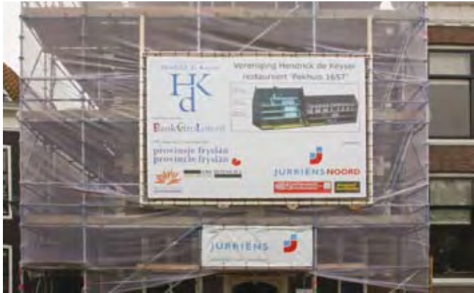
Harlingen, Noorderhaven Z-zijde 106, tijdens restauratie
