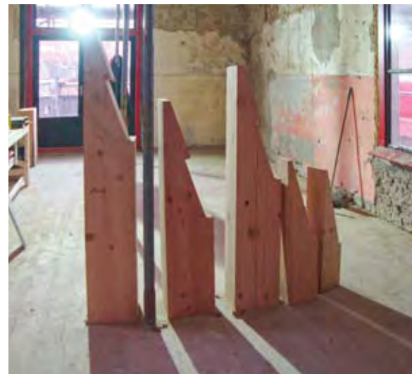
Schiedam, lange Achterweg 36-84, de nieuwe balkkoppen
