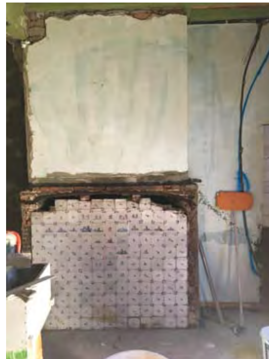
Veere, Markt 10, schouw voor en na restauratie
