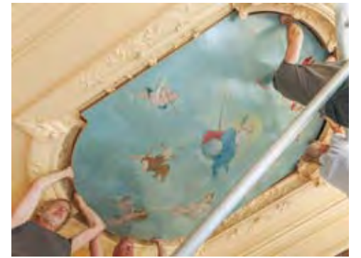
Gouda, Turfmarkt 142, Admiraalshuis, het terugplaatsen van het plafondstuk na restauratie (foto's Margreet Nijman)
