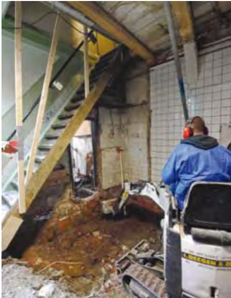
Amsterdam, Kattengat 2-4, verwijderen vloer
