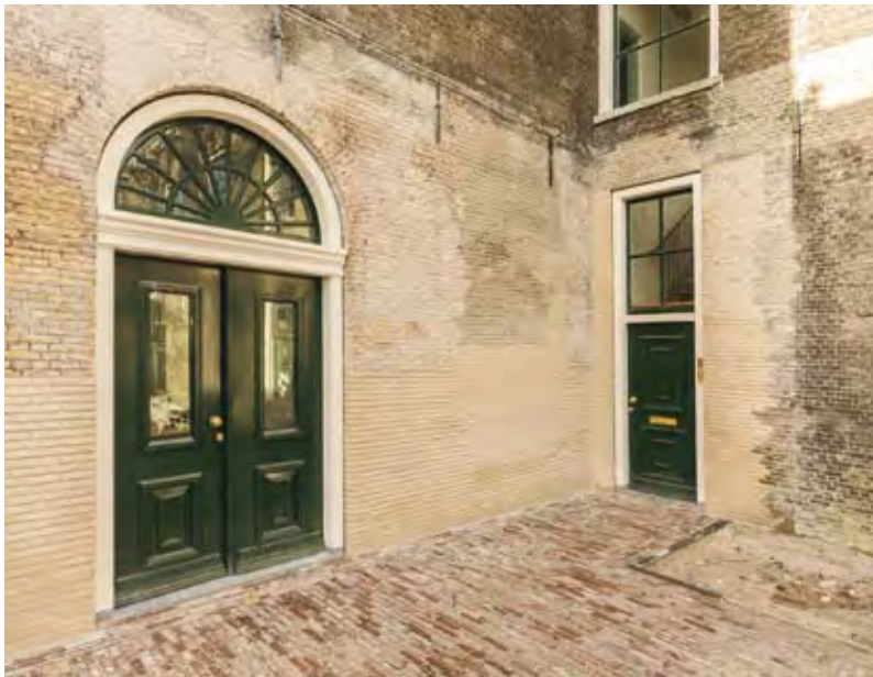
Schiedam, Lange Achterweg 36-84, hoofdingang tijdens restauratie (foto Zien24)
