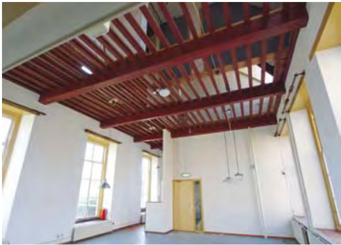
Honselersdijk, hofstraat 29, verwijderd plafond en vloerverdieping
