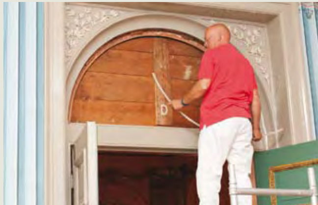
Een bovendeurstuk in de Dagelijkse eetkamer wordt uitgenomen (foto's Margreet Nijman)
