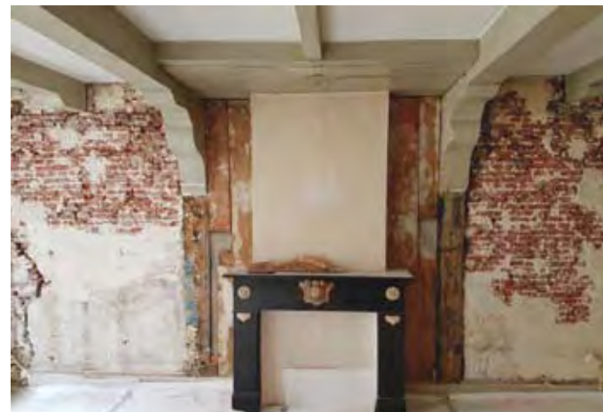
Amsterdam, Rapenburg 13, voorkamer verdieping voor restauratie
