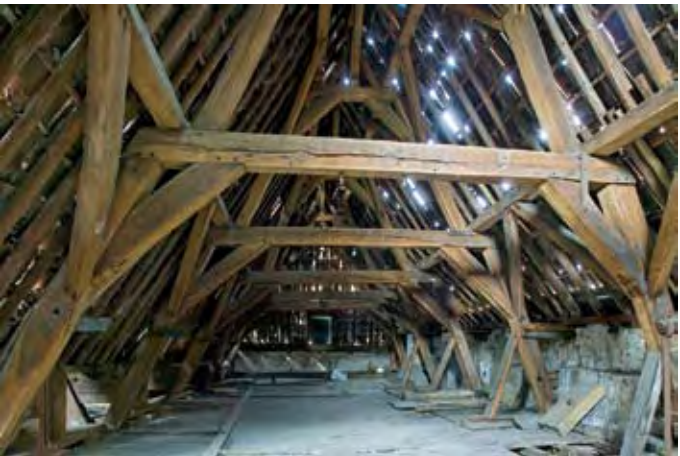
Dordrecht, Wijnstraat 153, Huis Rodenburch, 16de-eeuwse gebintconstructie in een van de parallelle kappen van het voorhuis
