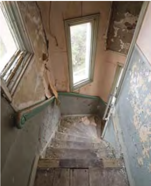
Afb. 22: Bij de verbouwing in 1902 kreeg Elandstraat 12 een bijzondere puntige traptoren, hier van binnen te zien (foto Arjan Bronkhorst)
