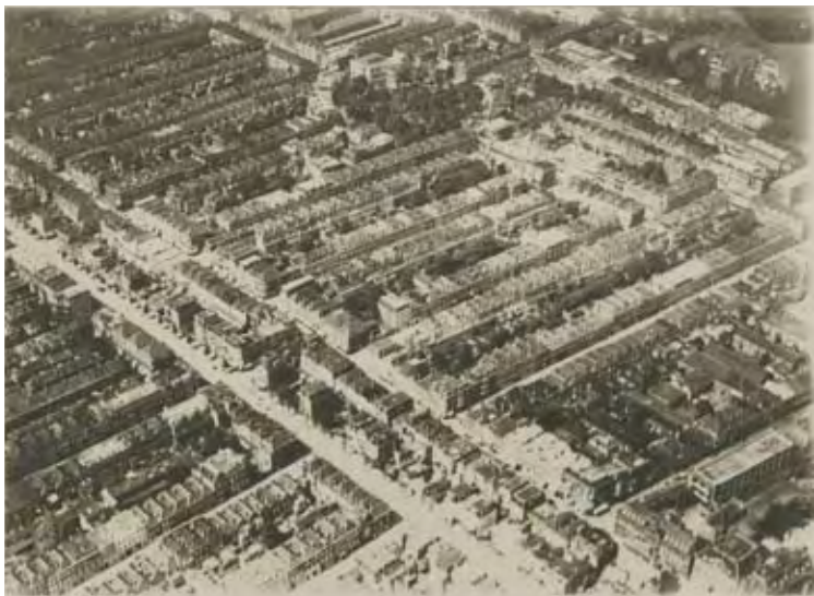
Afb. 11: Luchtfoto van het Zeesheldenkwartier, ca 1925. Centraal van links naar rechts de Elandstraat en de Piet Heinstraat. Duidelijk zichtbaar is de typische 19de-eeuwse structuur in rijtjesbebouwing (foto Haagse Beeldbank)
