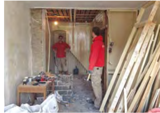
Gouda, Turfmarkt 140, ‘Cleyen Huysgen’, kamer op de begane grond tijdens restauratie
