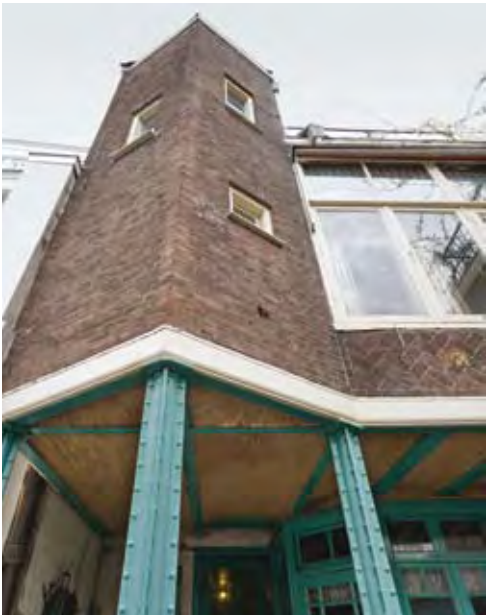
Afb. 28: Elandstraat 12, uitbouw aan achterzijde (foto Arjan Bronkhorst)
