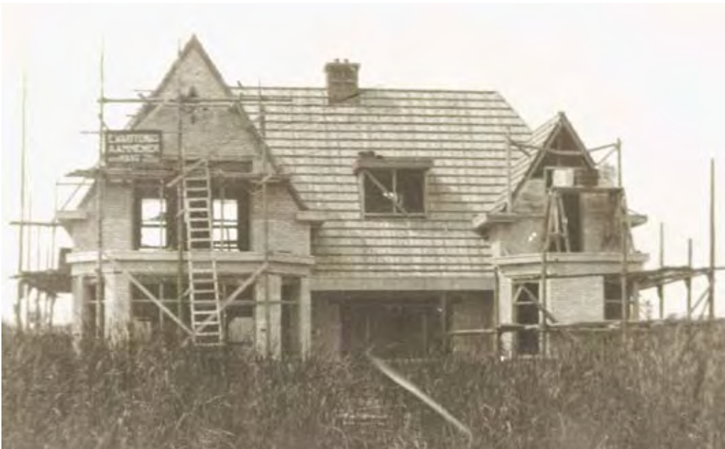
Afb. 55: Zonnehoek in aanbouw
