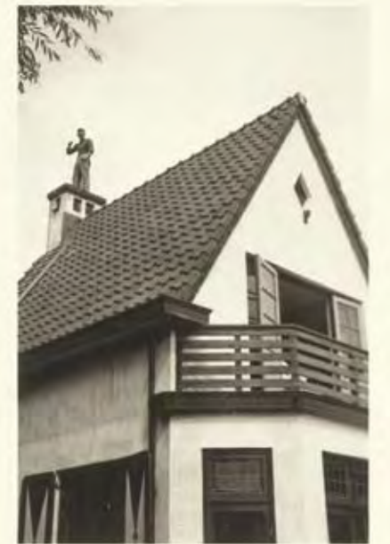
Afb. 58: Jan Hendrik van Dalen op het dak van Zonnehoek, 2 augustus 1937. De foto is getiteld 'Pa aan het schoorsteenvegen'
