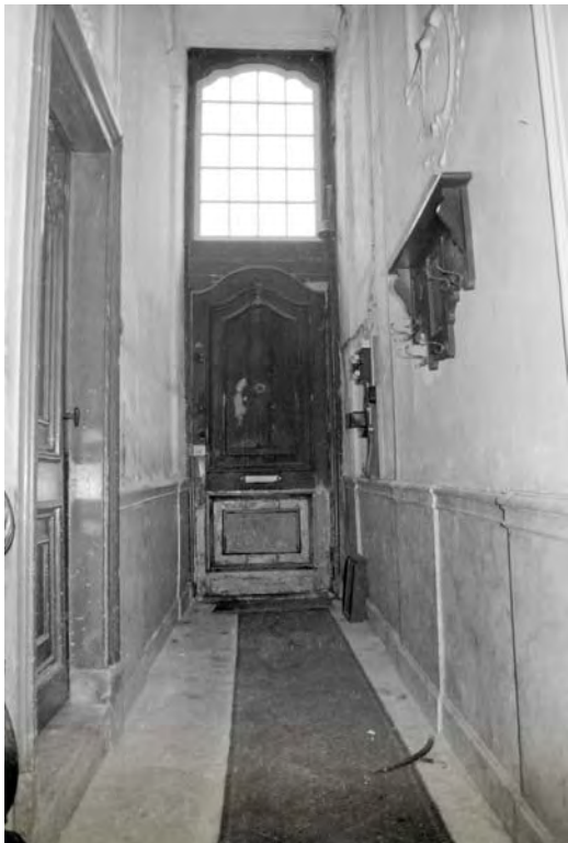
Afb. 6 en 7: Hal voor en na het begin van de restauratie (foto's J.M. Kooijman)
