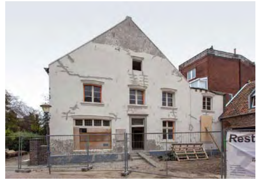
Tegelen, Sint Martinusstraat 2, de 'Gouden Berg', woonhuis tijdens restauratie (foto Ton Desar)
