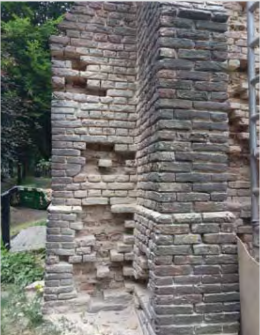
Herstel metsel- en voegwerk
