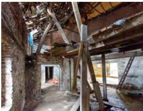
Tegelen, Sint Martinusstraat 2, de 'Gouden Berg', stutten van de constructie van het bedrijfsgebouw (foto Ton Desar)
