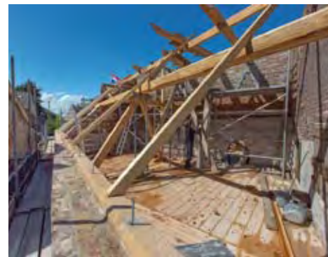
Tegelen, Sint Martinusstraat 2, de 'Gouden Berg', herstel van de kap van het bedrijfsgebouw (foto Ton Desar)
