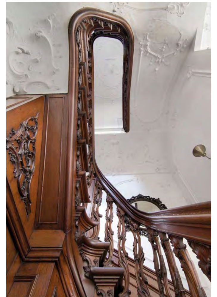
Afb. 18: Het stucwerk in het trappenhuis (foto Arjan Bronkhorst)
