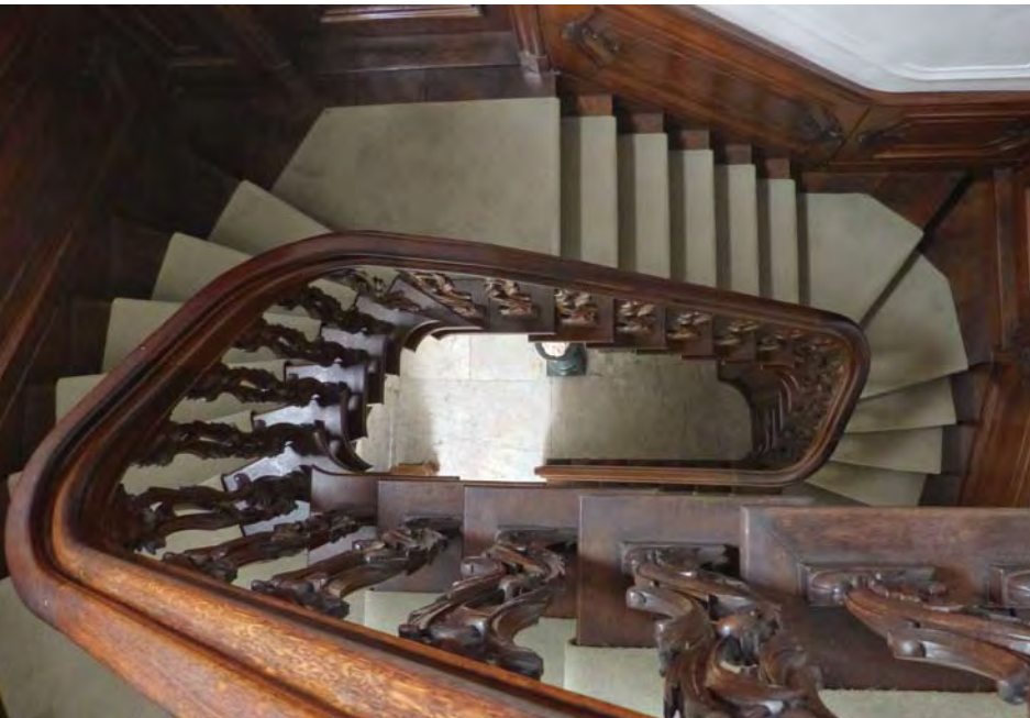
Afb. 28: Het trappenhuis van bovenaf gezien (foto J.M. Kooijman)
