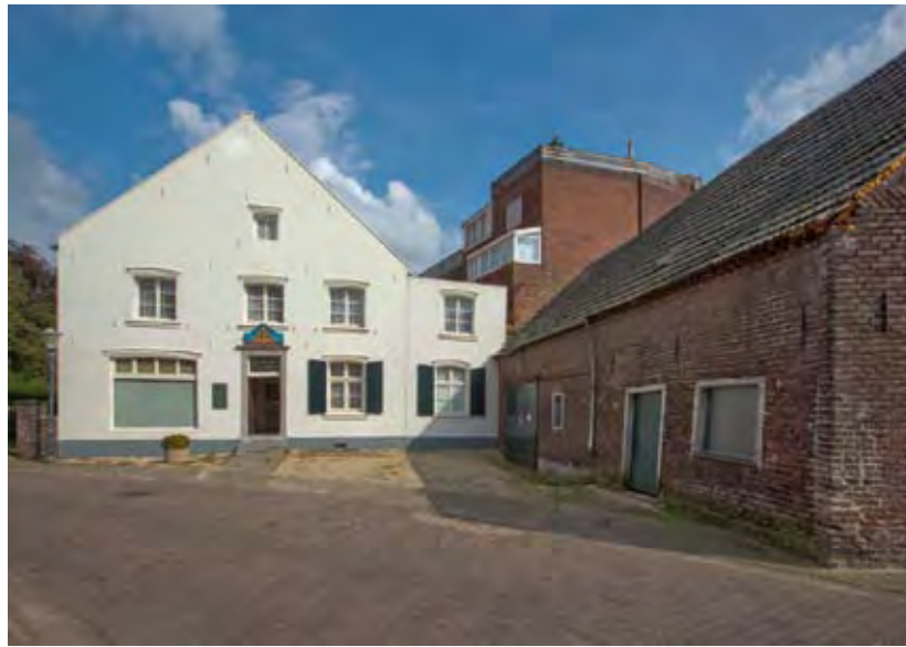
Tegelen, Sint Martinusstraat 2, de 'Gouden Berg', bedrijfsgebouw na ontmanteling kap (foto Ton Desar)
