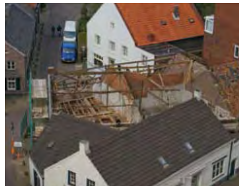
Tegelen, Sint Martinusstraat 2, de 'Gouden Berg', bedrijfsgebouw na ontmanteling kap (foto Ton Desar)
