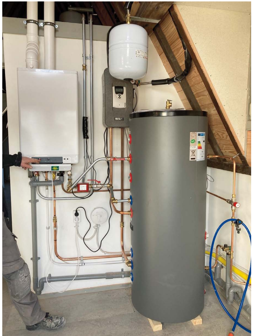
De warmtecollectoren zijn aangesloten op de cv-ketel.
