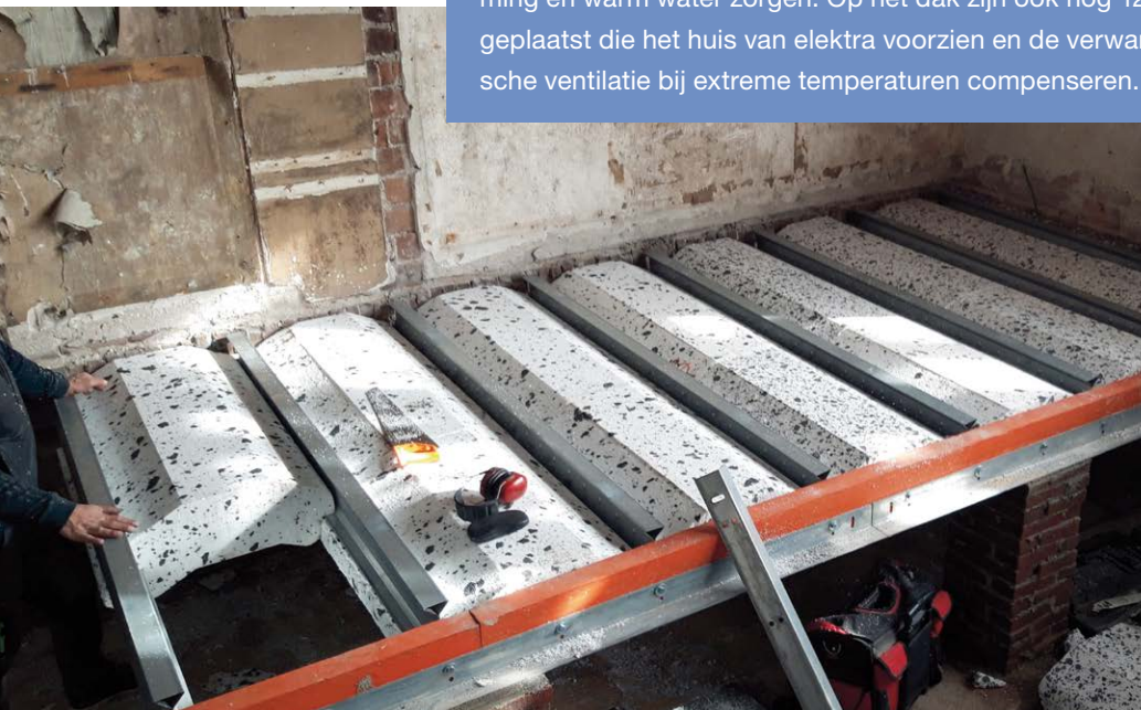
Vloerisolatie bij Thamerlaan 14.
