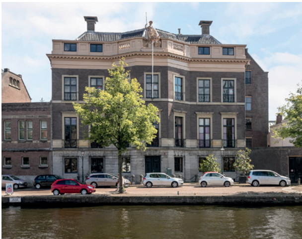
Kantoorunit in Huis Hodshon
