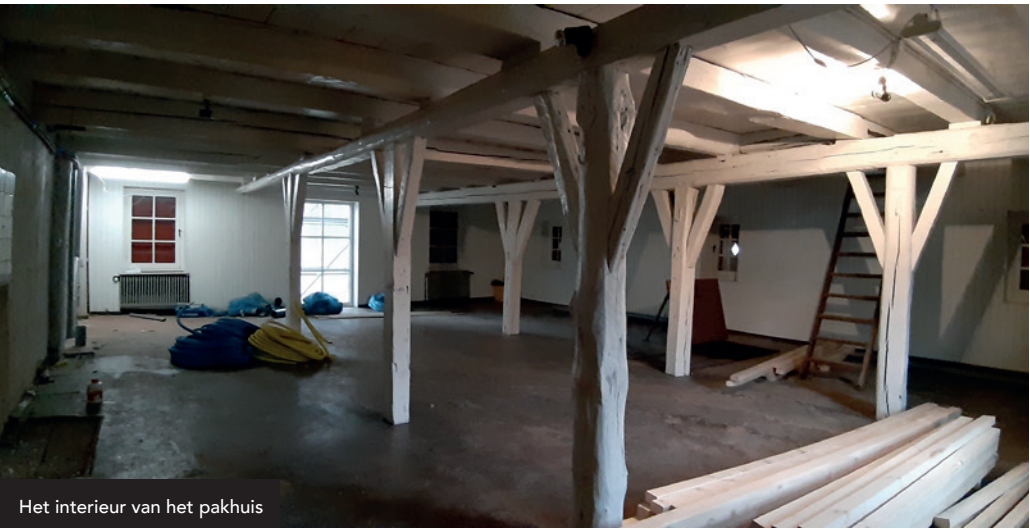
Het interieur van het pakhuis
