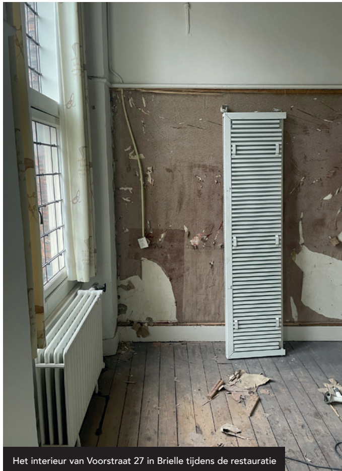
Het interieur van Voorstraat 27 in Brielle tijdens de restauratie
