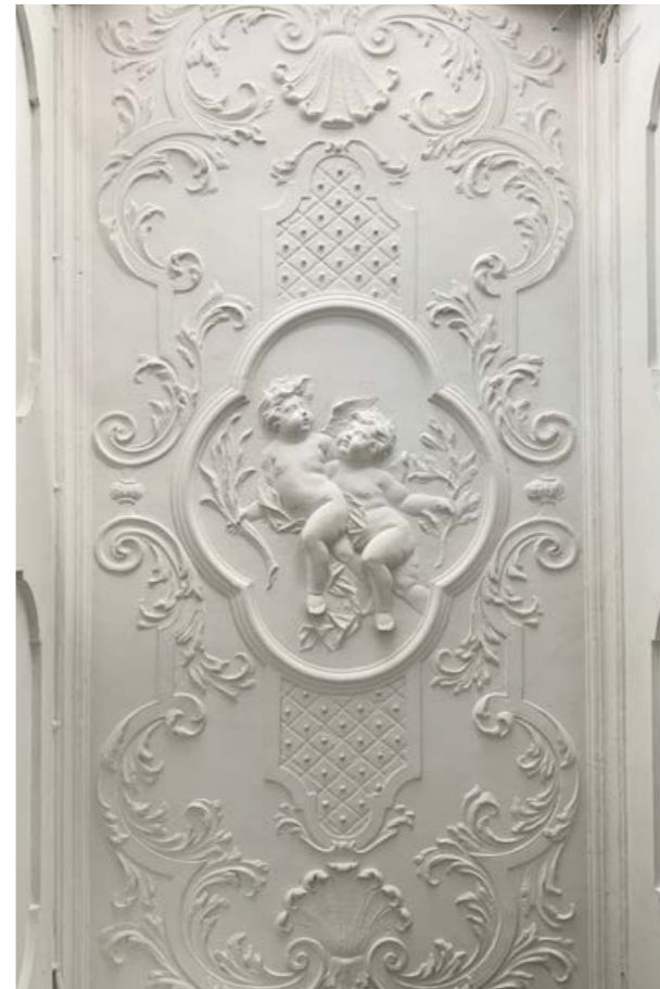
Stucplafond in late Lodewijk XIV-stijl in het voorste brede deel van de doorlopende gang (foto HdK)
