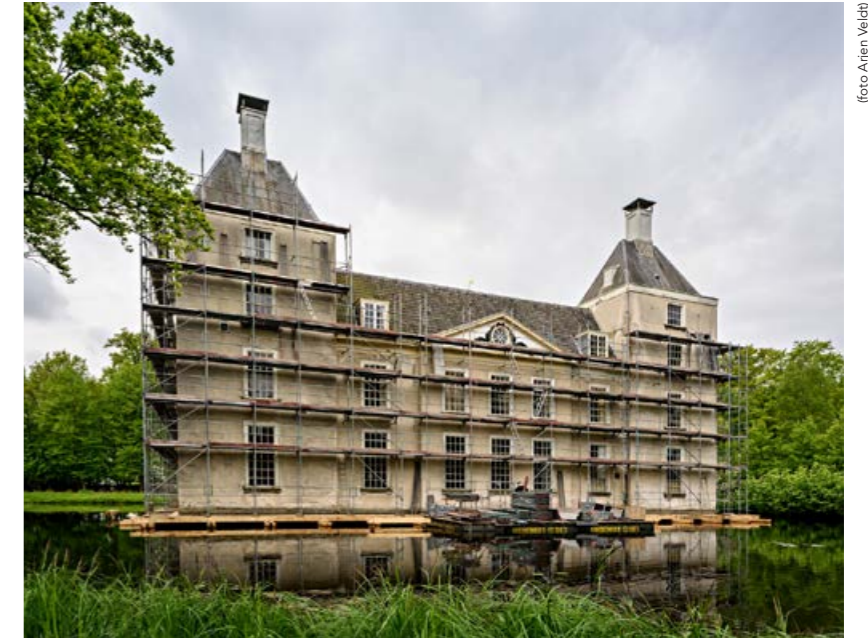
Huis te Warmond tijdens de restauratie
