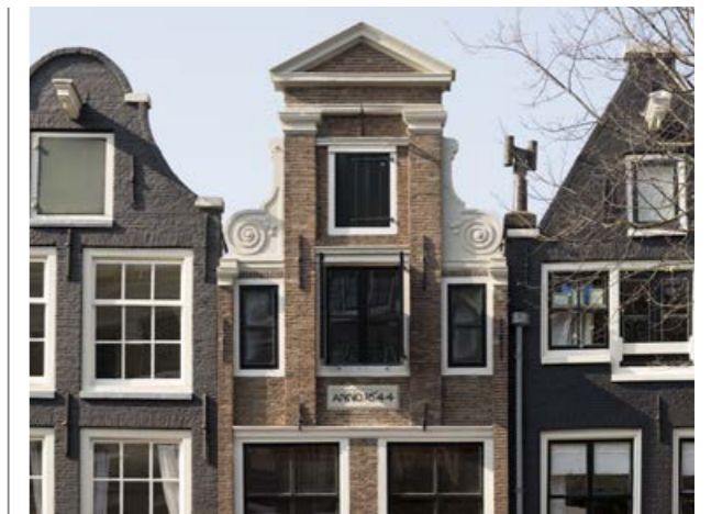
Topgevel met pilasters
