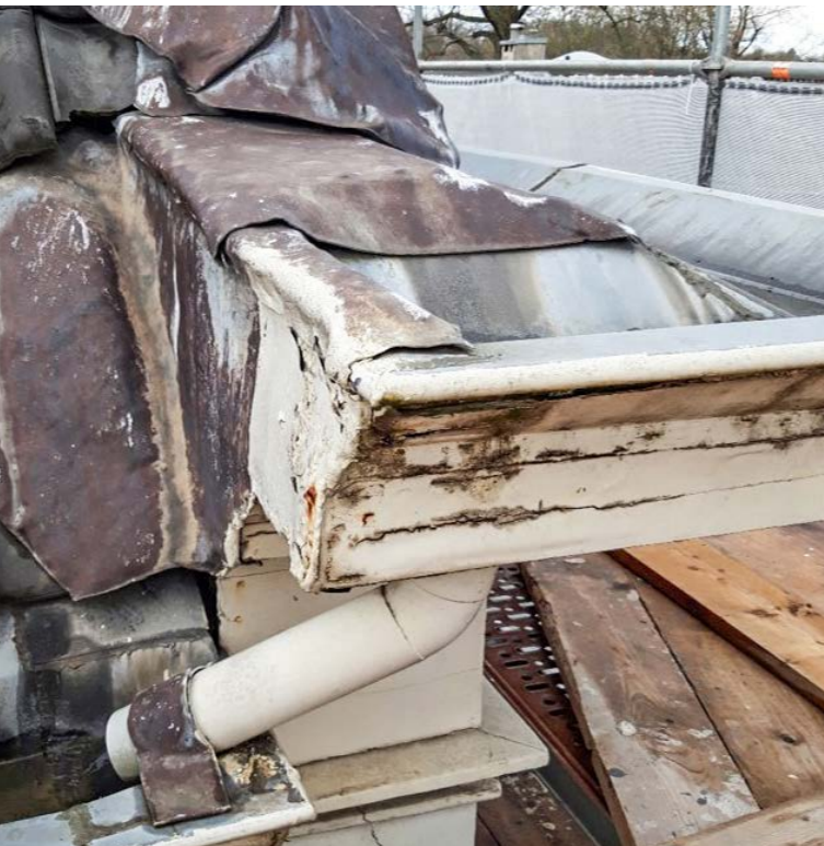
Goot voor en na restauratie
