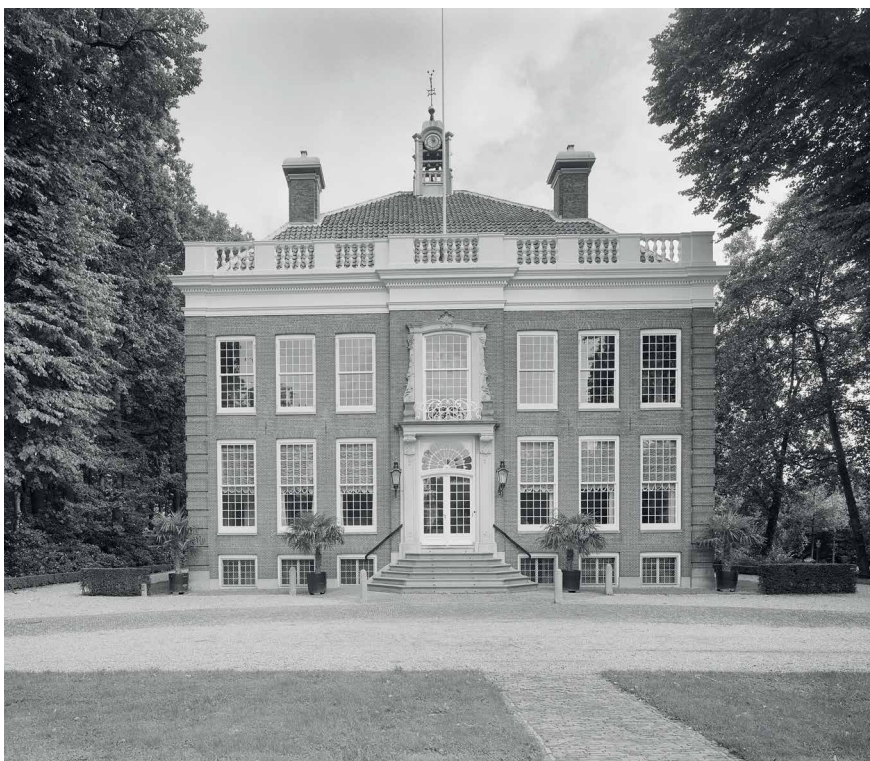
De voorgevel, na restauratie.
