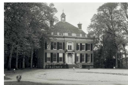
De voorgevel in vervallen staat, 1955.
