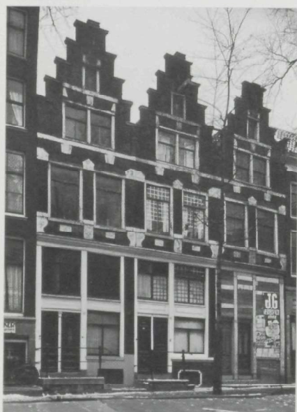
Foto omstreeks 1930. Onderpui met toegangen naar de boven- en benedenwoningen.
