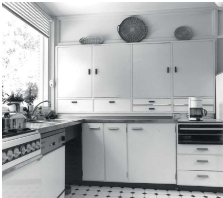
Keuken met stalen aanrechtblad, Bruynzeelkastjes en een grote doorgeefkast met warmhoudplaat. De oorspronkelijke glasstroken richting eetkamer zijn bij een verbouwing dichtgemaakt.
