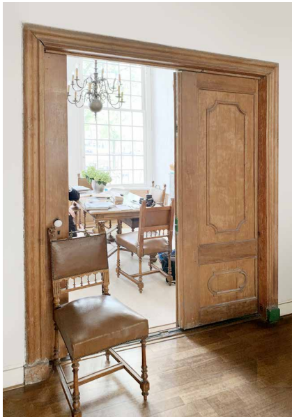
Dubbele deur tussen de voorkamer en de binnenkamer, een vroeg voorbeeld van een schuifdeur.
