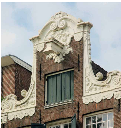
Halsgevel uit omstreeks 1720 in Lodewijk XIV-stijl. In het steenhouwwerk zijn loofwerk, lambrequins en ruitpatronen verwerkt.
