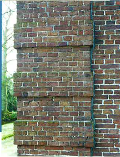
Afb. 14. Verschil in lagenmaat tussen het oude en het nieuwe werk (foto Kamphuis).
