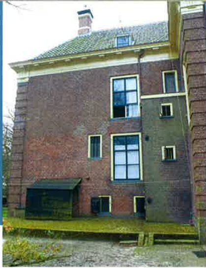
Afb. 13. Noordelijke zijgevel van de achterbouw. Door kleurverschillen is het 17de-eeuwse metselwerk nog duidelijk herkenbaar (foto Kamphuis).
