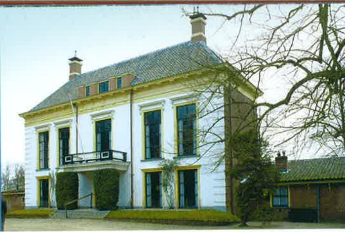
Afb. 4. Voorgevel in de 19de-eeuwse toestand. Bij een verbouwing in 1831 werden alle vensters vervangen en werd het metselwerk van een pleisterlaag voorzien. Bij een tweede verbouwing, in 1850, wijzigde men opnieuw de vensters van de verdieping (foto Kamphuis).
