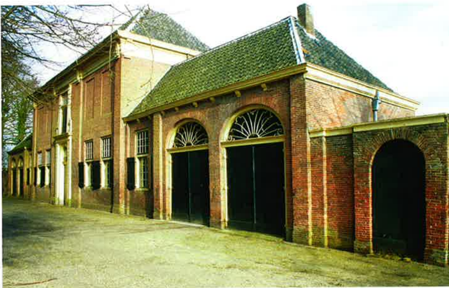
Afb. 18. Overzicht koetshuis. Het hogere middendeel bevatte de 'timmerwinkel' en de paardenstal, met daarboven een hooizolder. In de zijvleugels waren een tuigkamer (links), een bokkenstal (rechts) en vier stallen voor koetsen ondergebracht. Op de koppen van het langgerekte blok zijn onnuurde mestplaatsen (foto Kamphuis).
