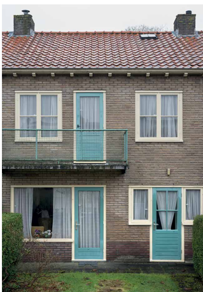
De achterzijde van het huis. Opvallend is de groenblauwe kleur van het balkonhekje en de deuren.
