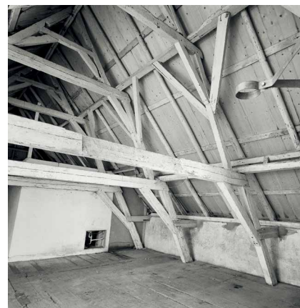
Kap met vier eikenhouten spanten, ieder opgebouwd uit twee gestapelde jukken en een nokspant. De constructie bestaat uit hergebruikte ingekorte 16de-eeuwse spanten van de oude state.
