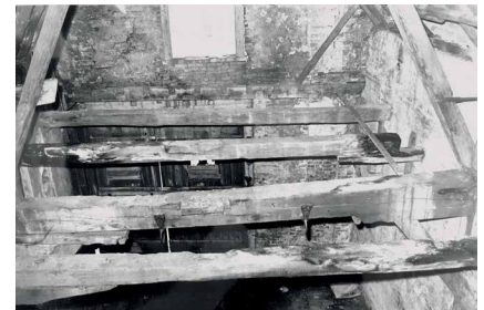
Balklaag woonhuis voor restauratie.
