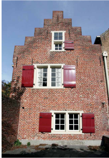
Achterzijde van het huis met trapgevel en ingemetseld kozijn.
