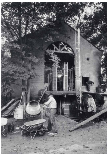
Tijdens de verbouwing, de trap tussen het voorgedeelte en de uitbouw.
