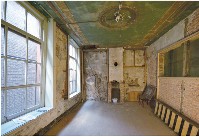
De opkamer voor de restauratie, met 19de-eeuws plafond en restanten van een schouwytje.
