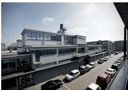
Voorgevel. De school is zorgvuldig gerestaureerd in 1998.
