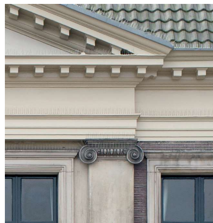
Kapiteel voorgevel. Het model voor de Romeins-Ionische kapitelen met platte voluten werd op instructie van de architect eerst in stuc gemaakt.
