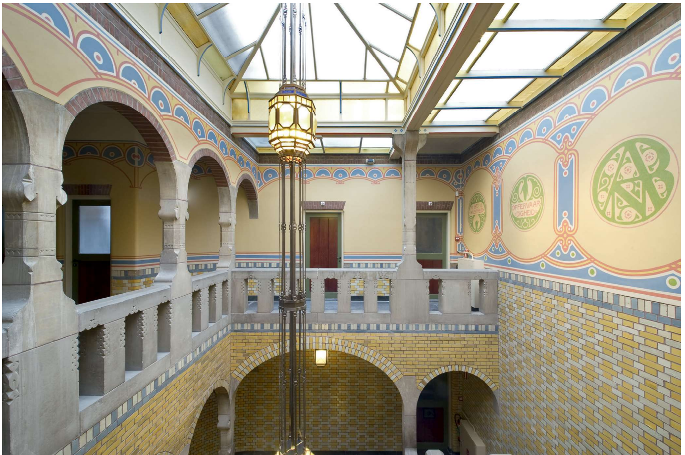
De vijf door Berlage ontworpen medaillons op de bovenste verdieping van het trappenhuis, gevonden onder later schilderwerk in 2010.
