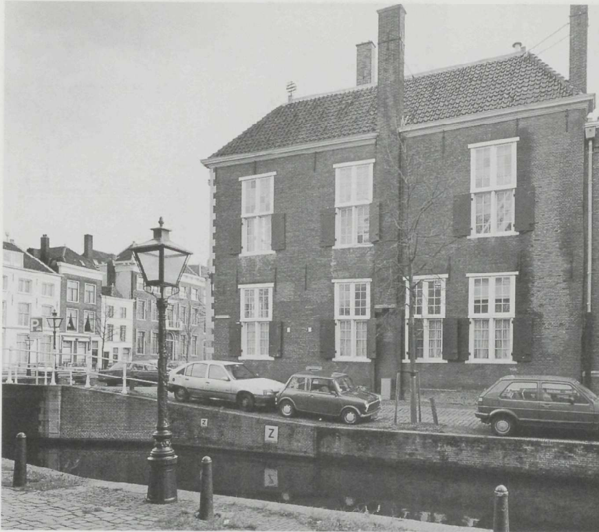
Zijgevel aan de Groen hazengracht. De zeven kruiskozijnen corresponderen met het aantal dat in het bestek wordt opgegeven. Het buitenlangs gemetselde rookkanaal is in deze vorm sinds de bouw aanwezig. Deze oplossing werd bedacht om onnodige doorbreking van de wandkasten in de bibliotheekzaal te voorkomen.
