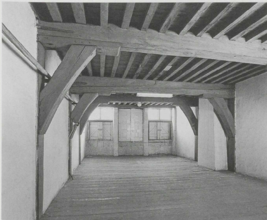
Detail balklaag boven de eerste verdieping. Laat-gotische bladconsole van natuursteen met eikenhouten peerkraalsleutelstuk.
