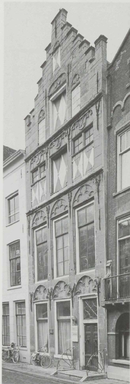
Trapegevel van omstreeks 1500, opgebouwd uit blokken Namense steen. De gevel werd waarschijnlijk kant en klaar per schip vanuit de omgeving van Luik aangevoerd en hier in elkaar gezet. Verschil in lagenmaat en decoratie tussen het beneden- en bovengedeelte. Oorspronkelijke sierankers. Stenen kruiskozijnen ter hoogte van de tweede verdieping. Moderne vensters voor de begane grond en eerste verdieping.
