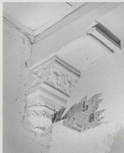
Detail balklaag boven de eerste verdieping. Laat-gotische bladconsole van natuursteen met eikenhouten peerkraalsleutelstuk.
