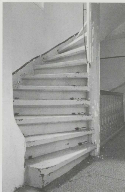
Aansluiting van het trappenhuis op het bewaarde deel van de traptoren. De spil is zestienhoekig.
