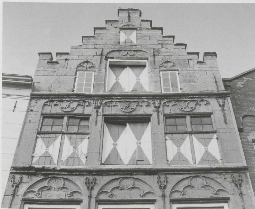
Trapegevel van omstreeks 1500, opgebouwd uit blokken Namense steen. De gevel werd waarschijnlijk kant en klaar per schip vanuit de omgeving van Luik aangevoerd en hier in elkaar gezet. Verschil in lagenmaat en decoratie tussen het beneden- en bovengedeelte. Oorspronkelijke sierankers. Stenen kruiskozijnen ter hoogte van de tweede verdieping. Moderne vensters voor de begane grond en eerste verdieping.
