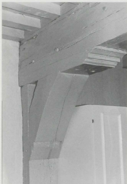
Detail houtskelet eerste verdieping. Rechte korbelen en sleutelstukken met kroonlijstprofiel. Dendrochronologisch onderzoek bevestigt een datering in het midden van de 16de eeuw.
