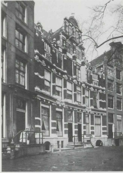
Toestand voor de restauratie: raamindeling 20ste eeuw en gewijzigde gevelbekroning.
