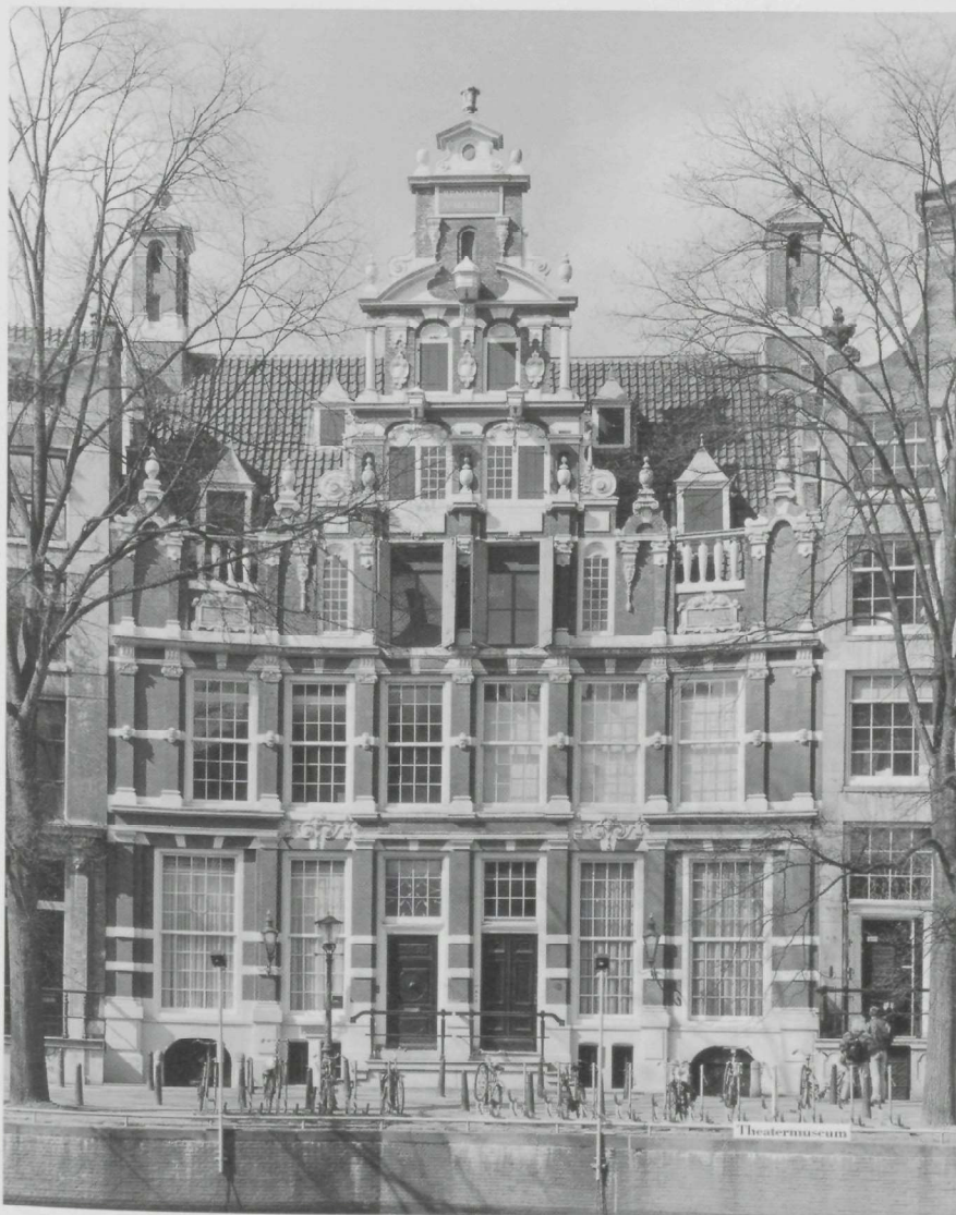
Gevel van dubbele breedte met maniëristische middentop, vermoedelijk naar ontwerp van Hendrick de Keyser. De bekroning werd bij de restauratie van 1970 opnieuw aangebracht. De oorspronkelijke toestand was bekend van de afbeelding in het Grachtenboek en van twee schilderijen van Jan van der Heijden.
