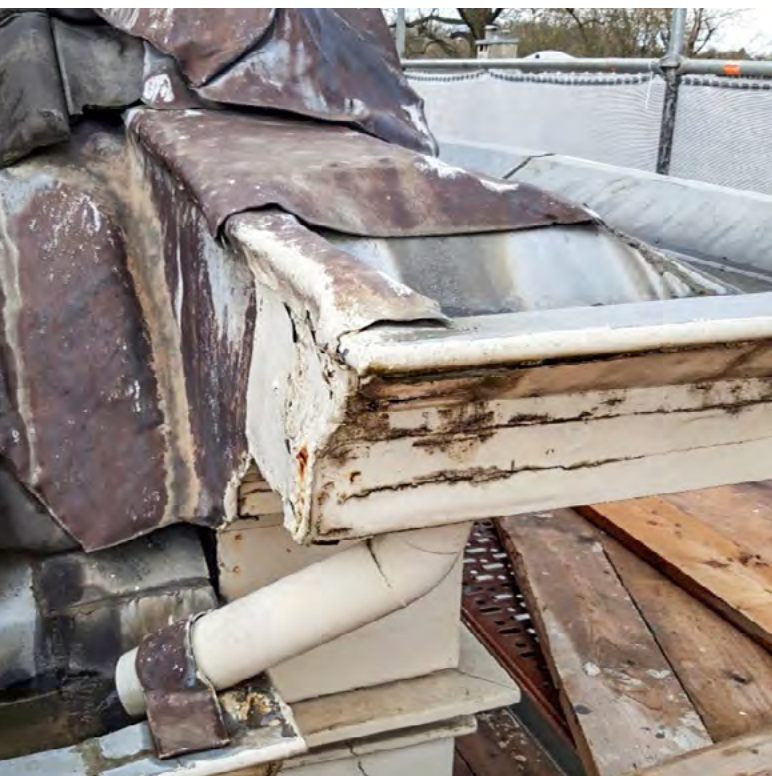
Goot voor en na restauratie
