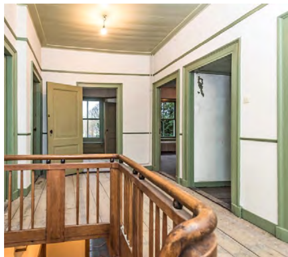
Overloop na restauratie
