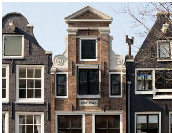
Topgevel met pilasters
