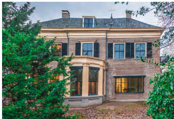
‘Huis Alpha’ na restauratie (foto Dijkhof Bouw)
